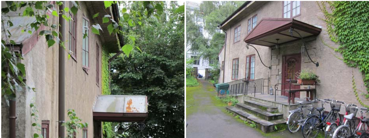
Utbygg i 1.etasje og taket over inngangssituasjonen har knapp detaljering.
