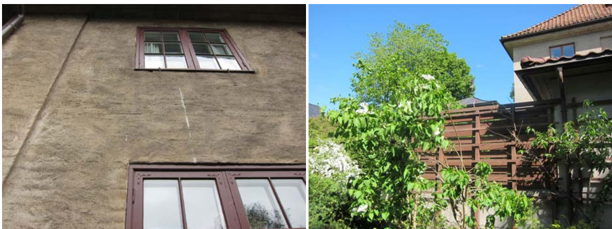
Mariahusets kalkpussfasade med brunmalte, sidehengslede vinduer. Naboens skjermvegg og espaliér (på garasjen).
